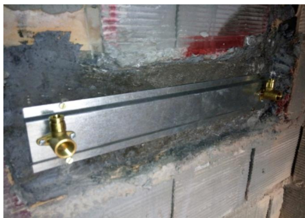
روش نصب شابلون شیرآلات در تهویه نوین
