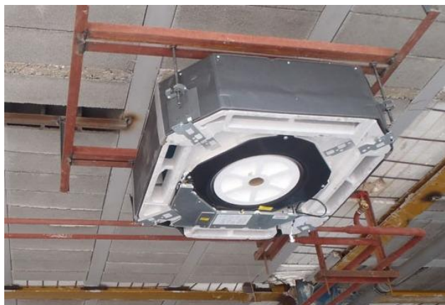
روش نصب فن کویل در تهویه نوین
